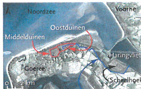
aanvoerleiding infiltratiewater Fig. 1. Ligging van de Oost- en Middelduinen en het innamepunt voor de kunstmatige infiltratie aan de Haringvliet.
