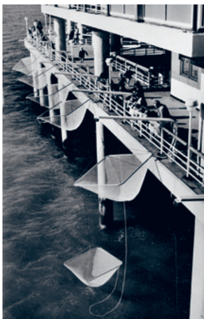
Figuur 2. Kruisnetten aan de nieuwe Pier van Scheveningen. Uitg. Van Leer's Fotodrukkerij, 1961
