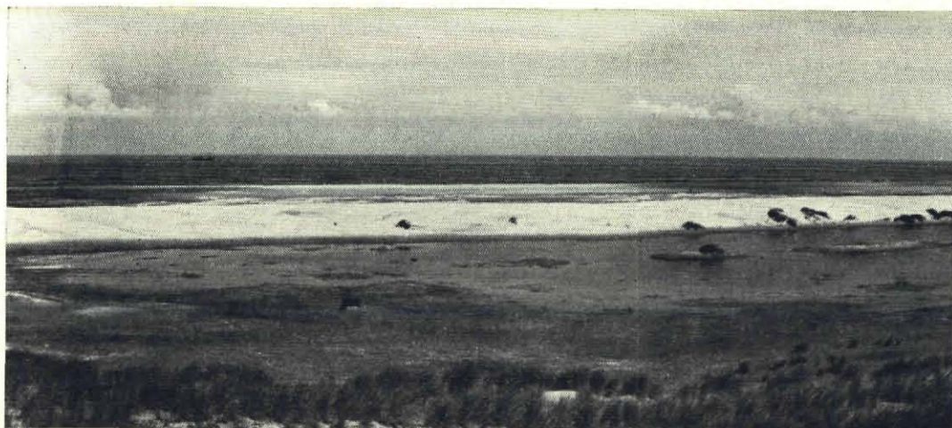
Fig. 3a. Stuijdijk, met dood materiaal door de Rijkswaterstaat te Goeree aangelegd.
