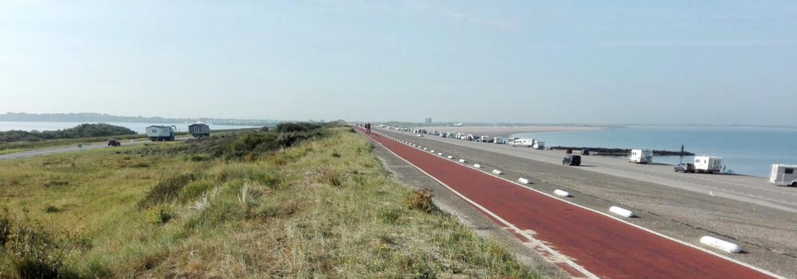
Figuur 40. De Brouwersdam aan de Goereese kant. Links onderaan het talud op een gedeelte met weinig struweel loopt raai 7. Brouwersdam, 7 september 2021.
